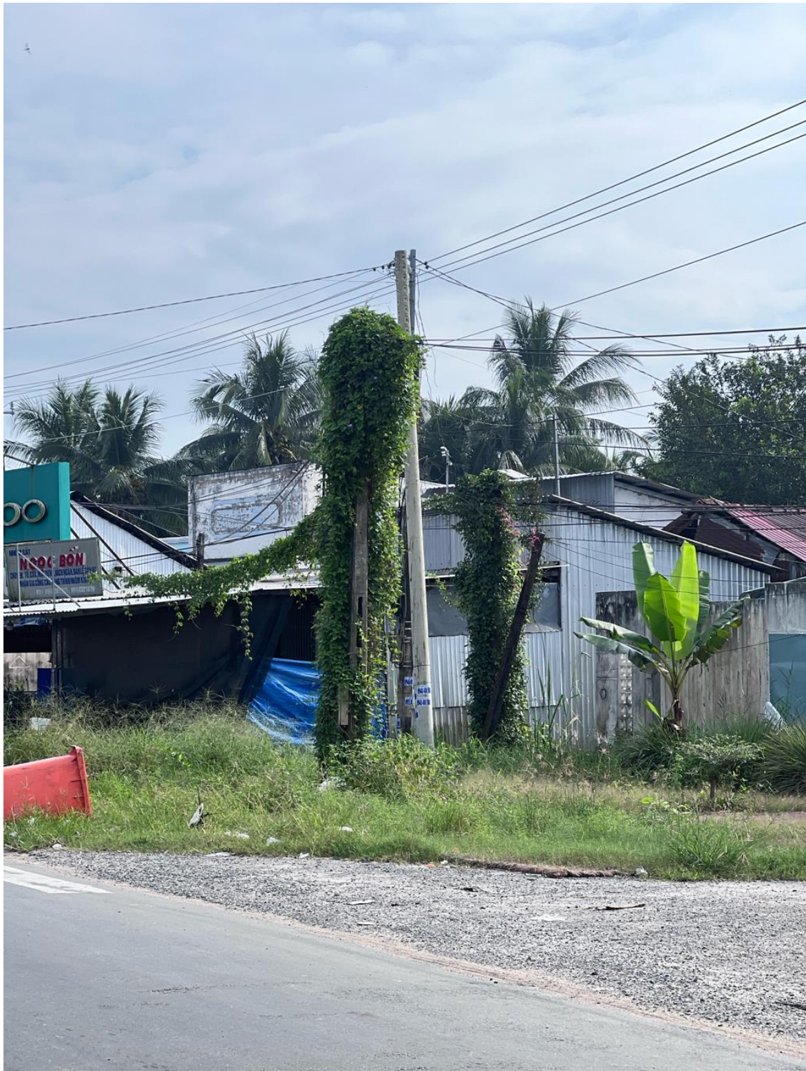
Hình ảnh hiện trạng trụ điện bị ngã trước Trạm Y tế xã Nhị Long, tỉnh Vĩnh Long do người dân cung cấp
